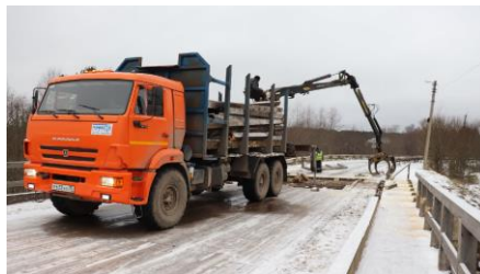
Разбор деревянного моста
