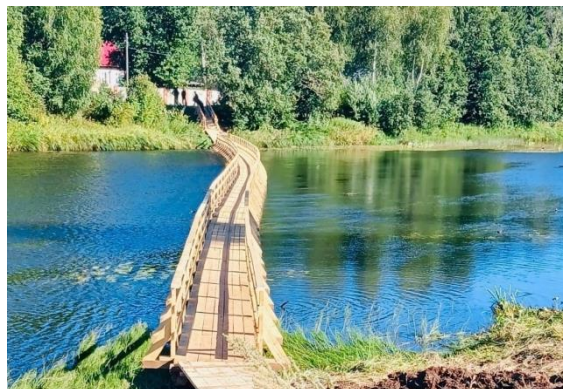
Наплавной мост в с.Борисово-Судское
