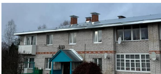
Ремонт кровли г. Бабаево, ул. Зеленая, д.9а
