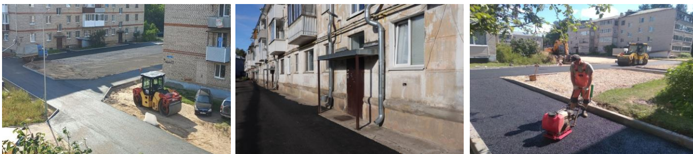
Дворовые территории в г. Бабаево после выполнения работ по благоустройству
