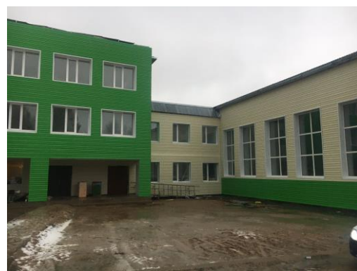
Ремонт в МБОУ «Борисовская сош»
