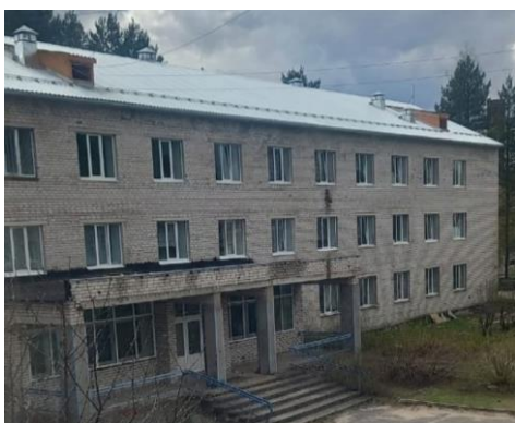
Ремонт кровли терапевтического отделения Бабаевской ЦРБ
